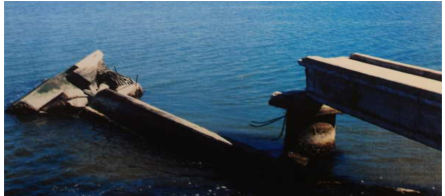
Figura 3: Estado actual del duque de alba N° 1.
