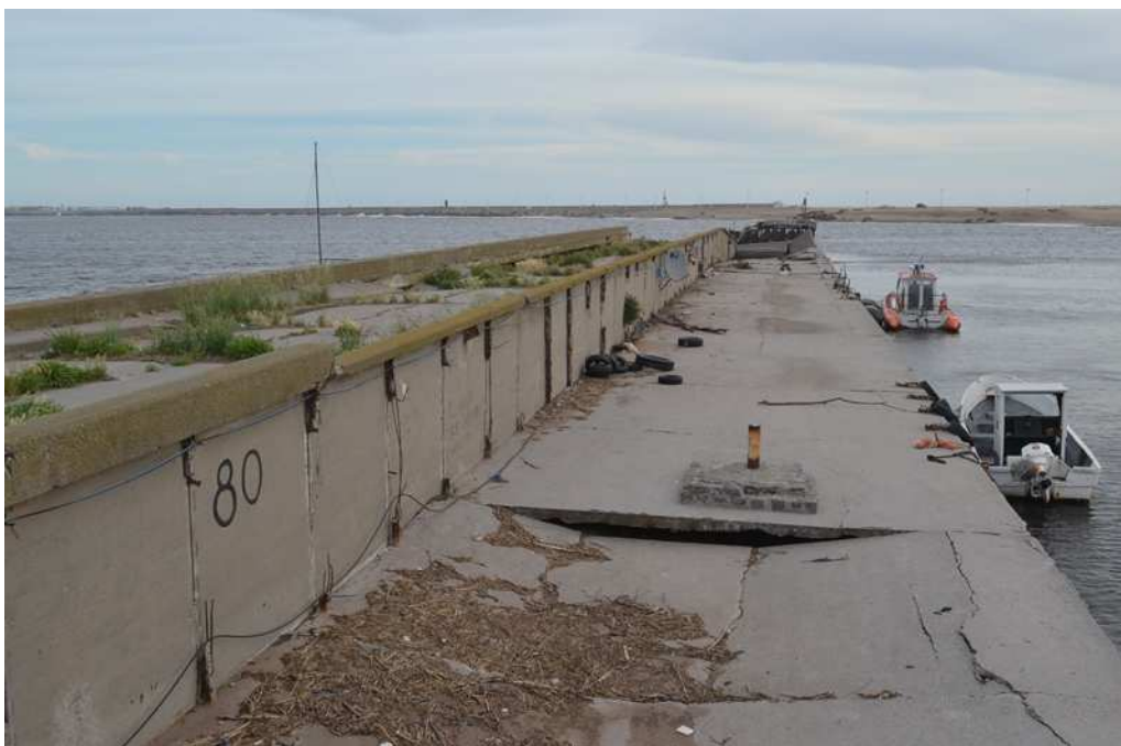
Figura 3: Estado actual del espigón de defensa.
