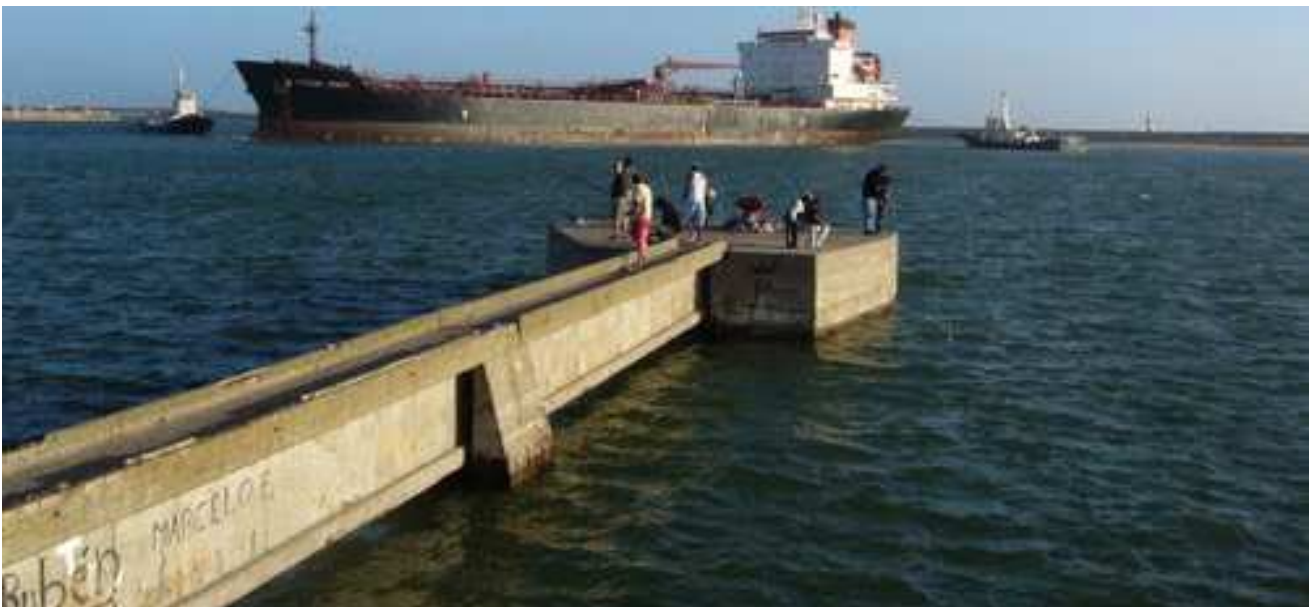
Figura 4: Estado actual del duque de alba N° 2.
