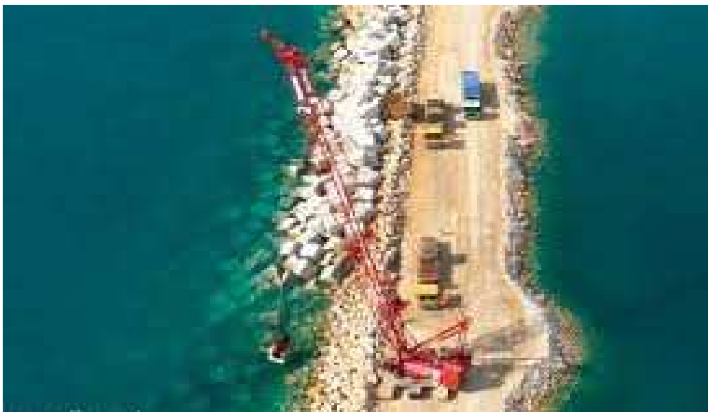
Figura 23: Operativa de colocación o retiro de una coraza de bloques utilizando una grúa sobre orugas.
