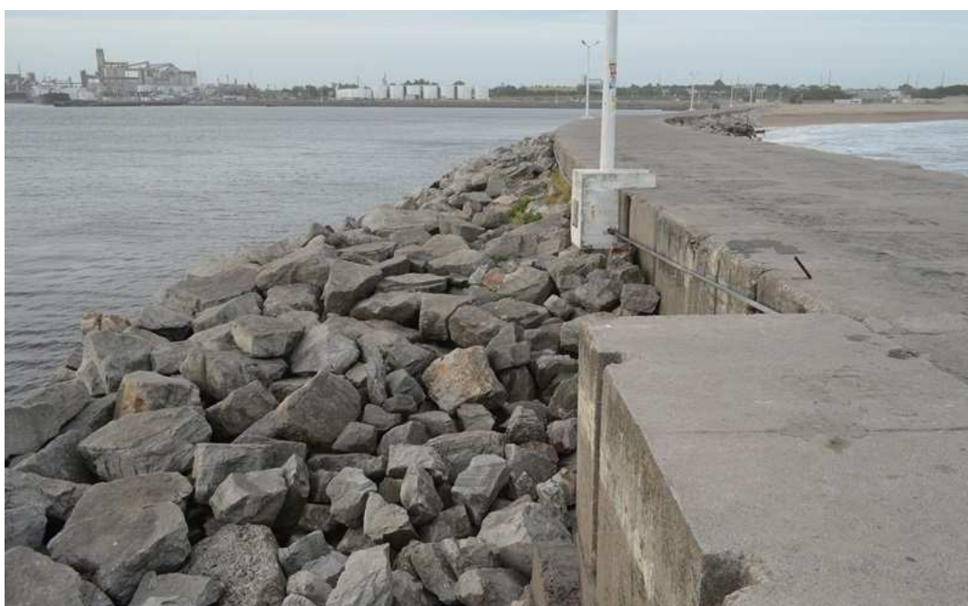
Figura 1: Fin de escollera Norte, lado recinto portuario.
