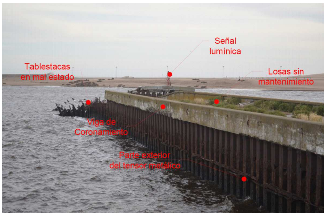
Figura 2: Estado actual del espigón de defensa.
