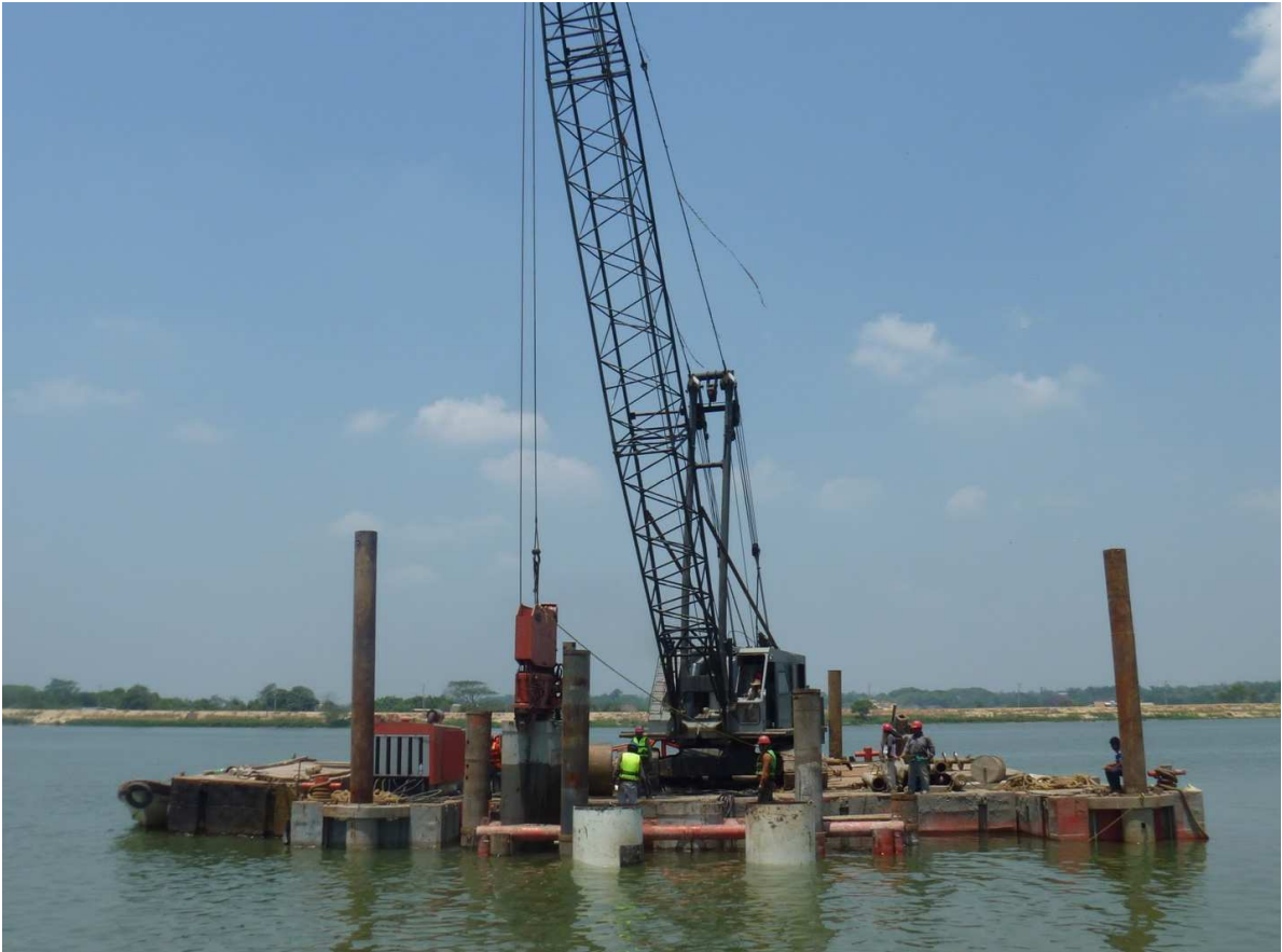
Figura 25: Grúa sobre pontón arrancando un pilote.
