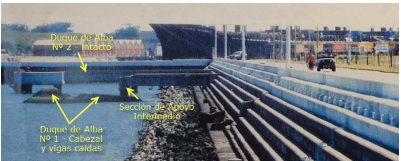
Figura 2: Vista de los duques de alba desde la escollera Norte.
